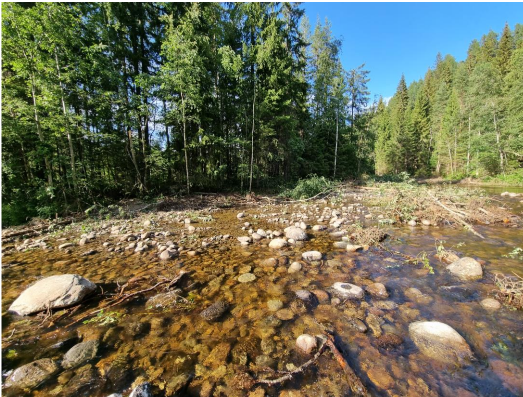
Figur 44. Efterbild Objekt 8. Uppströmsvy mot rensvall 1766 RR efter åtgärd. Rensvallen är nu bortgrävd och på den återkspade flacka strandlinjen syns det att vattendraget har fått en större bredd på grund av den förstärkta nacken som dämmer in vattnet.
