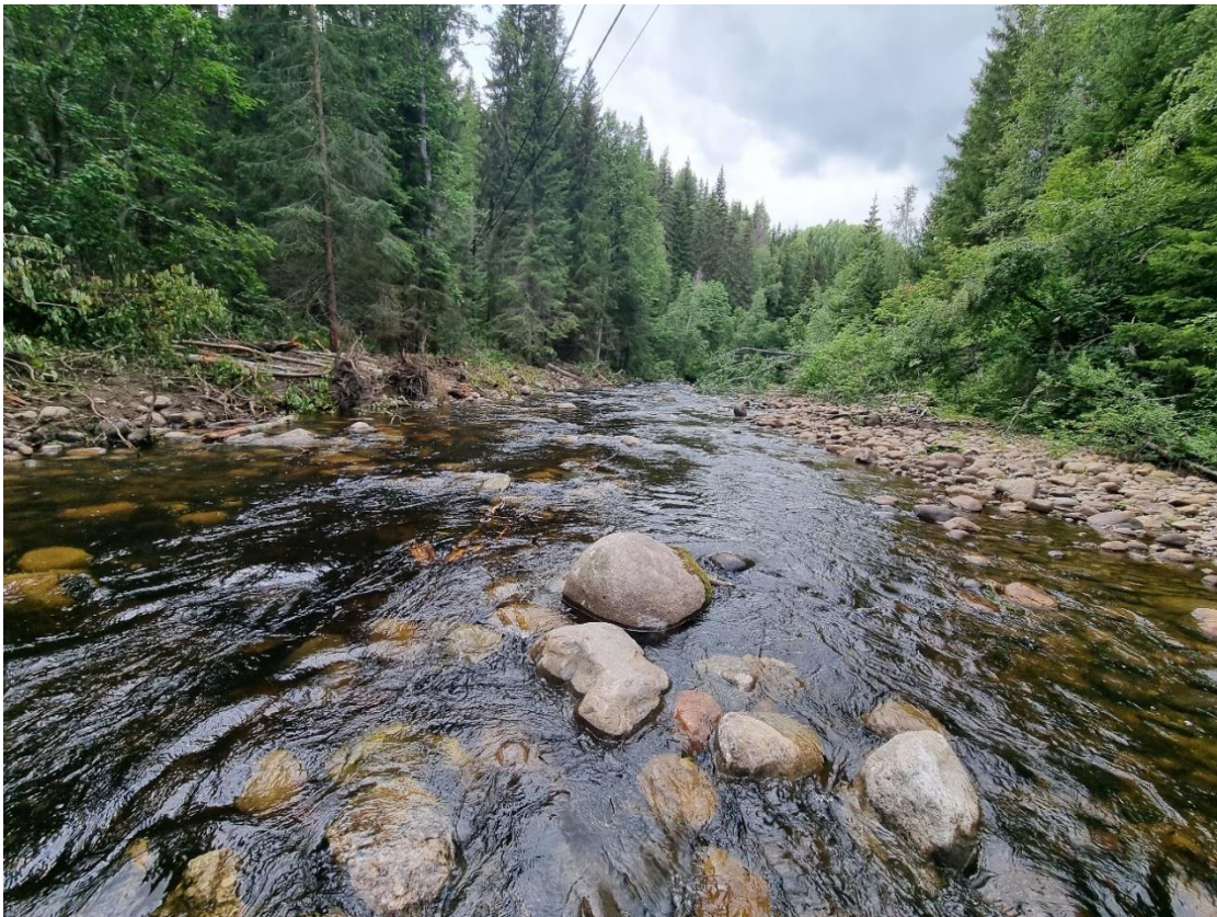
Figur 7. Efterbild objekt 1 uppströmsvy där stenmaterial från rensvallen på RR har återförts till vattnet och en flackare strand återskapats.
