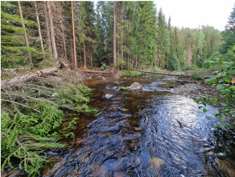
Figur 33. Efterbild Objekt 6. Nedströmsvy. Mellersta delen av rensvall 1770. Här har rensavallen plockats ut och fördelats ut i vattnet samt förstärkt nacken nedströms för dämna in mer vatten i de nu återskapade mer flacka standkanterna som ger vattendraget mer kontakt med svämplanen. Ett inlopp till 536 definierades och materialet som utvanns användes för att skapa uddstruktur på motsatt sida för att få ån att meandra mer samt tvinga in mer vatten i den återöppnade sidofåran.
