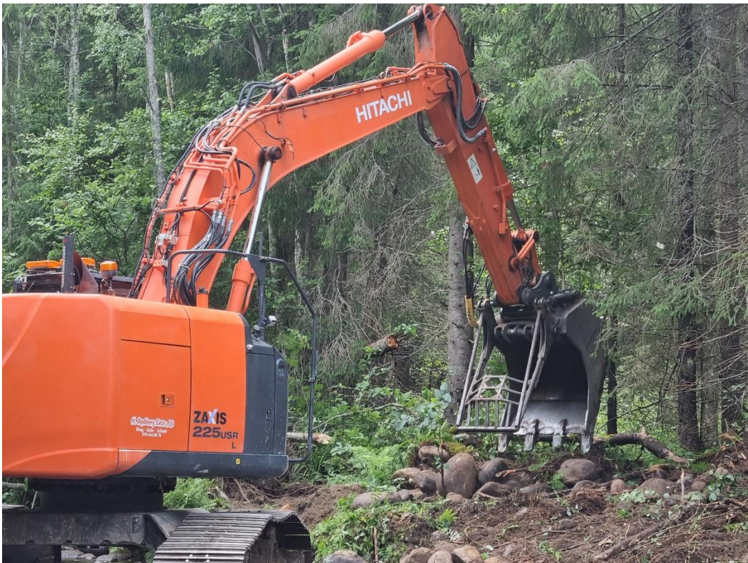
Figur 9. Arbetsbild när stenarna i vallen plockas ut ur vallen vid objekt 1.
