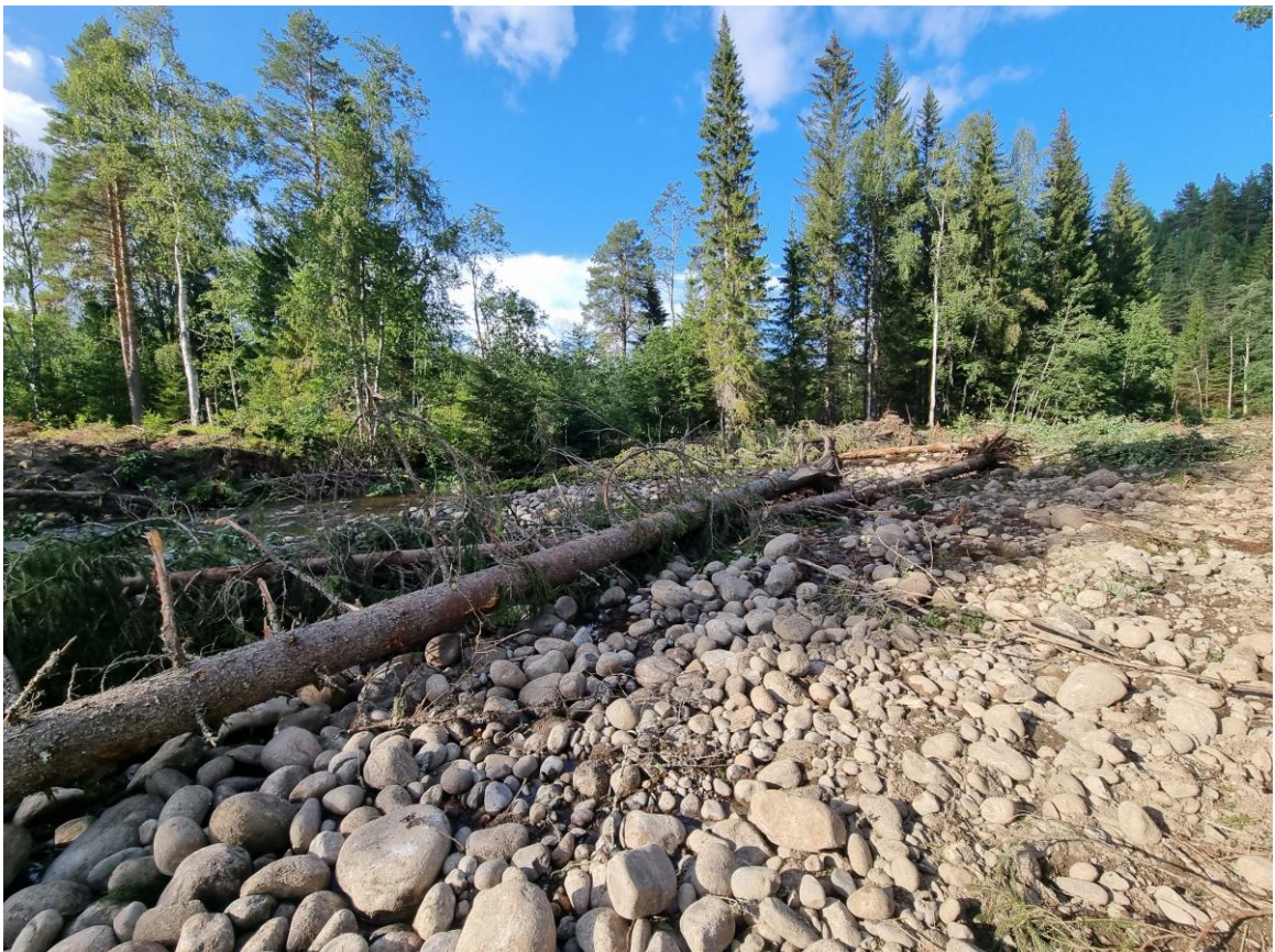
Figur 50. Efterbild Objekt 9. Uppströmsvy vid schaktvall 1764 RL efter åtgärd. Här syns den återskapade flacka stranden som kommer vara en viktig miljö för bland annat yngel vid högre flöden.
