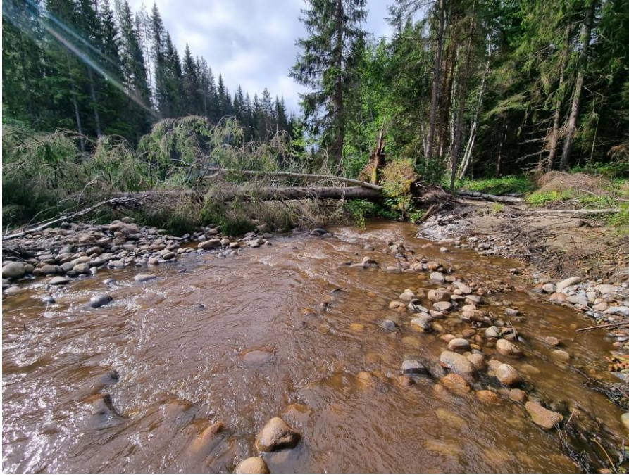
Figur 65. Förebild komplettering 2 nedströmsvy mot redan aktiv sidofåran på RL-sidan och det sedimenterade inloppet till den återöppnade sidofåran på RR-sidan. Här ses också att en stor gran vält, och som utnyttjades för att anlägga proppen för tvinga in mer vatten i inloppet.
