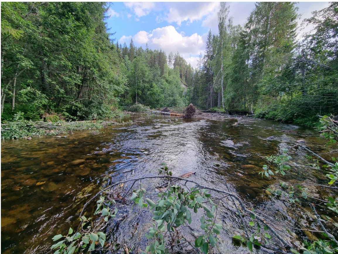
Figur 40. Efterbild Objekt 7. Här har materialet från rensvallarna i skogen RL plockats ut och användts till att förstärka nacken nedströms. Det öppnades även upp ett höglödesinlopp till sidofåra 535 som ses centralt i bilden RL.
