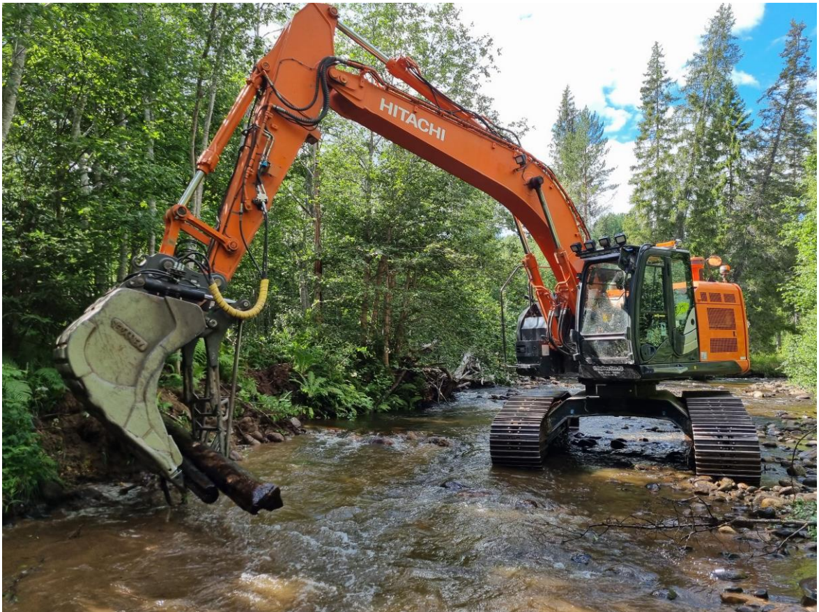
Figur 29. Arbetsbild Objekt 5. Uppströmsvy där enkelstockkistan mittemot 1770 plockades bort och strandkanten fläckades ut.
