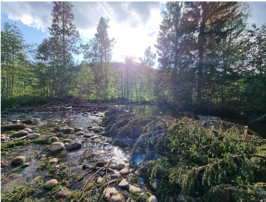
Figur 52. Efterbild nedströmsvy Objekt 9. Här har rensvallen på höger sida (RR) centralt i bilden grävts bort och fördelats ut i vattnet för att höja nacken och därmed få mer kontakt med svämytorna. Vi fördjupade även ytterkurvan för att få en djupare del av en annars flack men variabel bottenstruktur.
