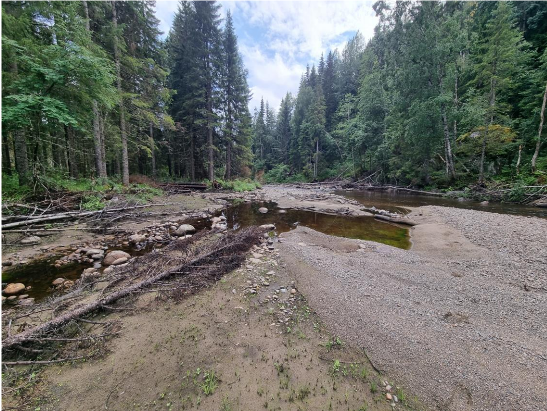
Figur 62. Förebild komplettering 1. Nedströmsvy mot sidofåran som öppnades 2022 men som sedimenterats igen. Här synns det stillastående vattnet som har skapats på grund av att området har sedimenterat igen på grund av för lågt flöde mot inloppet.
