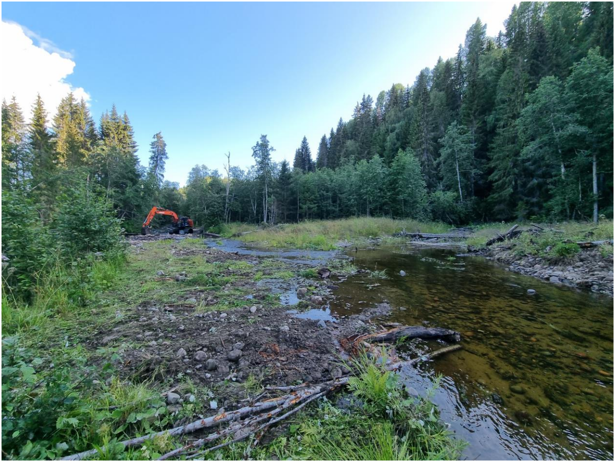
Figur 70. Efterbild Komplettering 3. Nedströmsvy in i höglödesinloppet (RR) som nu är aktivt.
