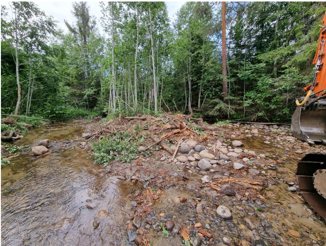
Figur 31. Arbetsbild Objekt 5. Vy mot inloppet till den aktiva sidofåran mitt emot 1772. Här har en del av massorna plockats bort och använts nedströms inloppet i huvudfåran för att tvinga in mer vatten i inloppet. Innan åtgärden gick ca 10 % av vattnet in i sidofåran och efter ca 30 %.
