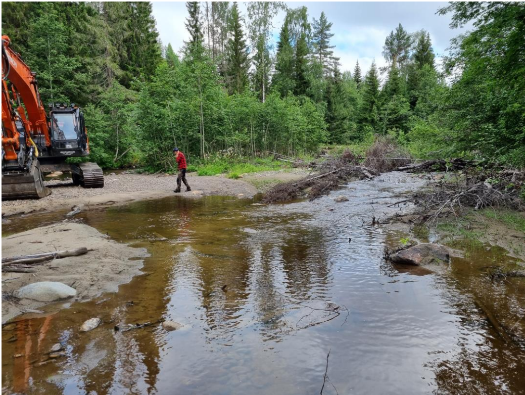
Figur 61. Efterbild komplettering 1 strax uppströms sidofåran som öppnades 2022. Här synns tydligt att det stillastående vattnet är borta eftersom flödet ökat pga åtgärden som genomfördes vid Figur 59.
