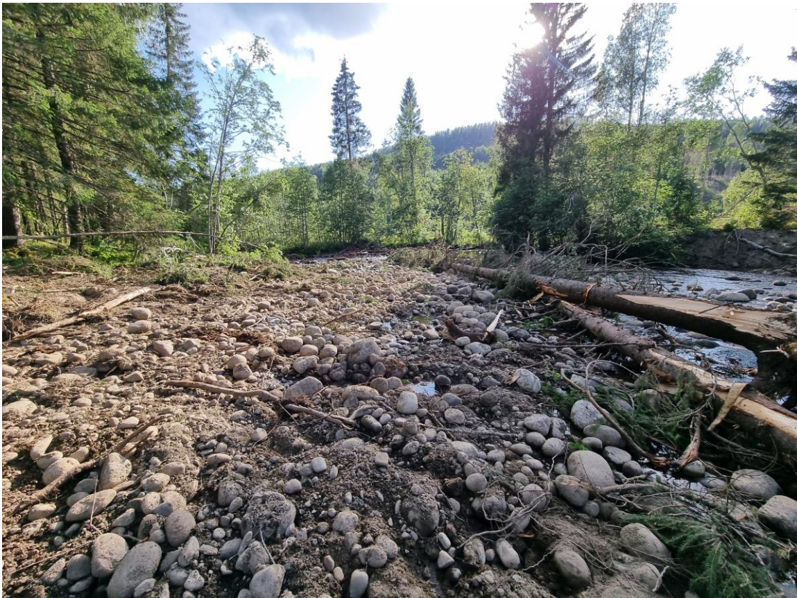
Figur 48. Efterbild Objekt 9. Nedströmsvy mot schaktvall 1764 RL efter åtgärd. Schaktvallen grävdes bort och en stor flack grundmiljö återskapades. Materialet som utvanns utnyttjades till att förstärka nacken i ån som skapade en bredare fåra med mer kontakt med svämplanen.
