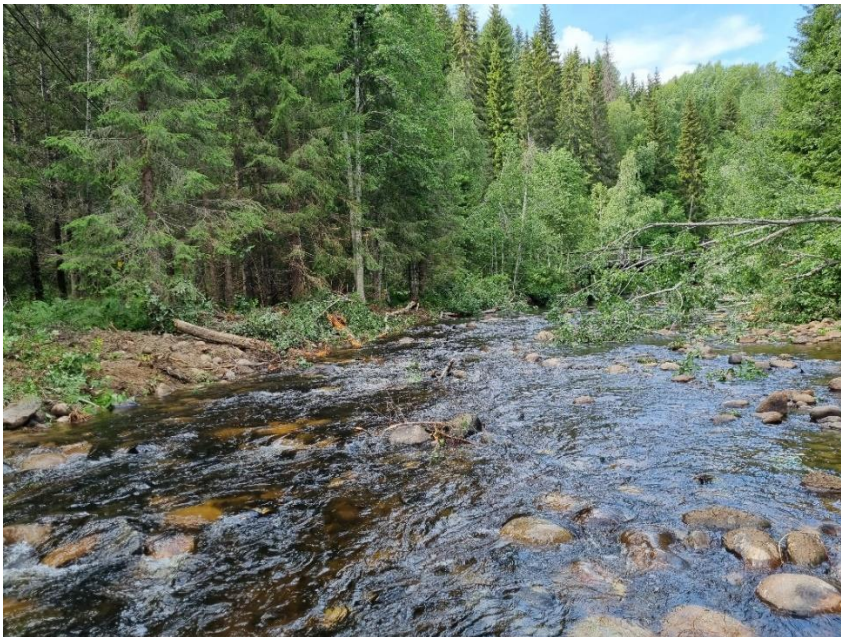
Figur 3. Efterbild objekt 1 från samma vy som ovan där sten från vallen lagts ut i ån och en flackare strandzon återskapats.
