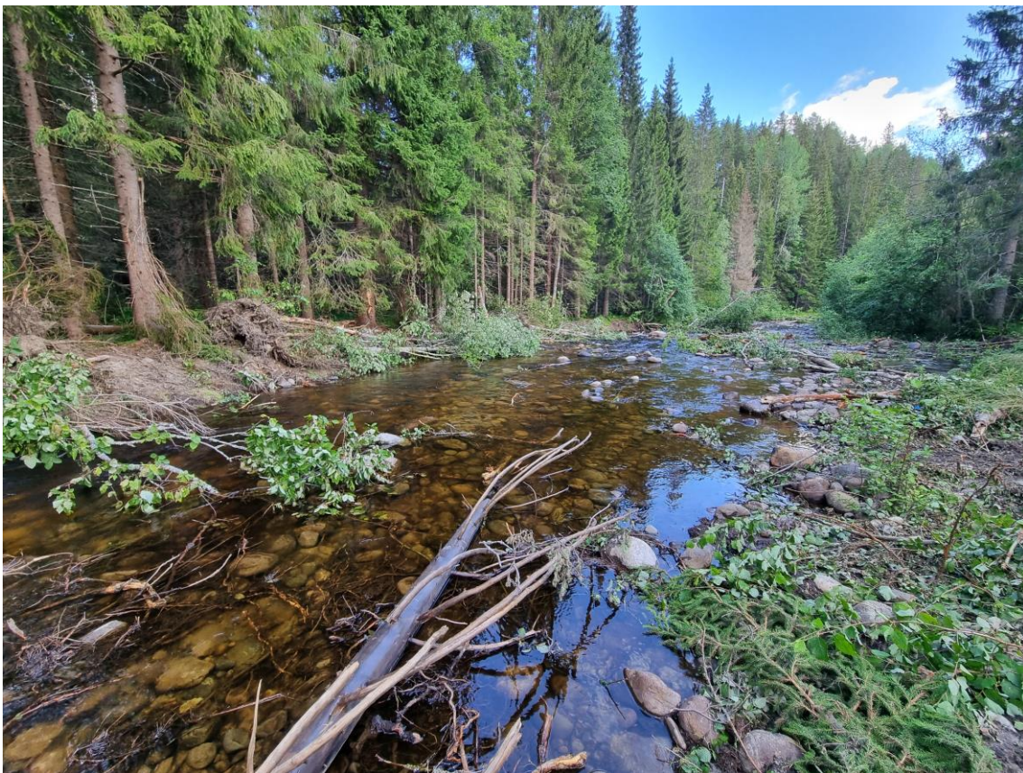
Figur 36. Efterbild Objekt 6. Nedströmsvy. Nedre delen av rensvall 1770. Här har rensvallen plockats ut och fördelats ut i vattnet samt förstärkte nacken nedströms för att dämna in mer vatten i de nu återskapade mer flacka standkanterna som ger vattendraget mer kontakt med svämplanen.
