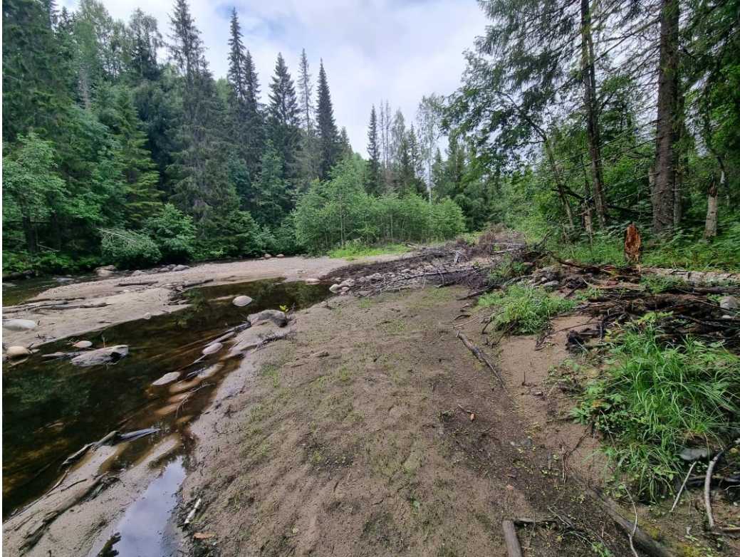
Figur 60. Förebild komplettering 1 strax uppströms sidofåran som öppnades 2022. Här synns tydligt att stillastående vatten har skapats på grund av att området har sedimenterat igen på grund av för lågt flöde mot inloppet.
