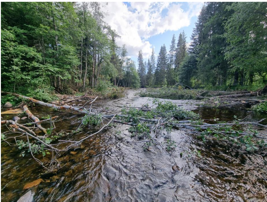
Figur 20. Efterbild Objekt 4. Nedströmsvy rensvall 1773 RL. Vattnet trycks nu mot återskapad uddstruktur och sedan över till den nu flacka strandkanten där den höga och långa rensvallen tidigare blockerade vattnet från att rinna in i svämytorna mot skogen RL. Dämningen av det återförda stenmaterialet ger en bredare fåra med en mer varierad bottenstruktur och därmed fler livsmiljöer för vattenorganismer.
