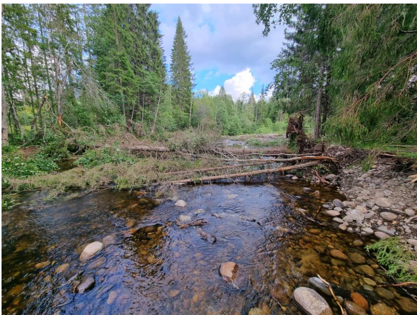
Figur 17. Efterbild Objekt 3. Nedströmsvy rensvall 1775 RR och nedre delen av 1776. Majoriteten av 1775 utgrävd och en flackare strandkant är återskapad. I nedersta delen har uddstruktur återskapats samt död ved lagts ut för att förstärka uddens förmåga att trycka vatten till motsatt sida. 1776 är också utgrävd och flackad för att få en bredare fåra med mer svämyta. Mycket sten återfördes till vattendraget för att återskapa en mer varierad bottenstruktur.
