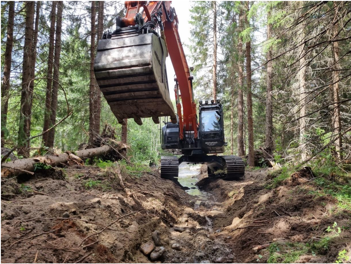
Figur 34. Arbetsbild Objekt 6. Återöppnandet av högflödesinlopp till den bortvallade sidofåran 536 på gång.
