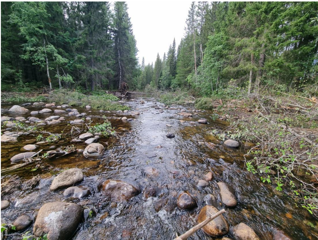
Figur 19. Efterbild Objekt 3. Uppströmsvy mot 1775 RR och 1776 RL. På RL-sidan ses den nu flackare strandzonen som kommer tillåta vattnet vid högre flöden att svämma ut i svämplanen som tidigare var bortvallade.
