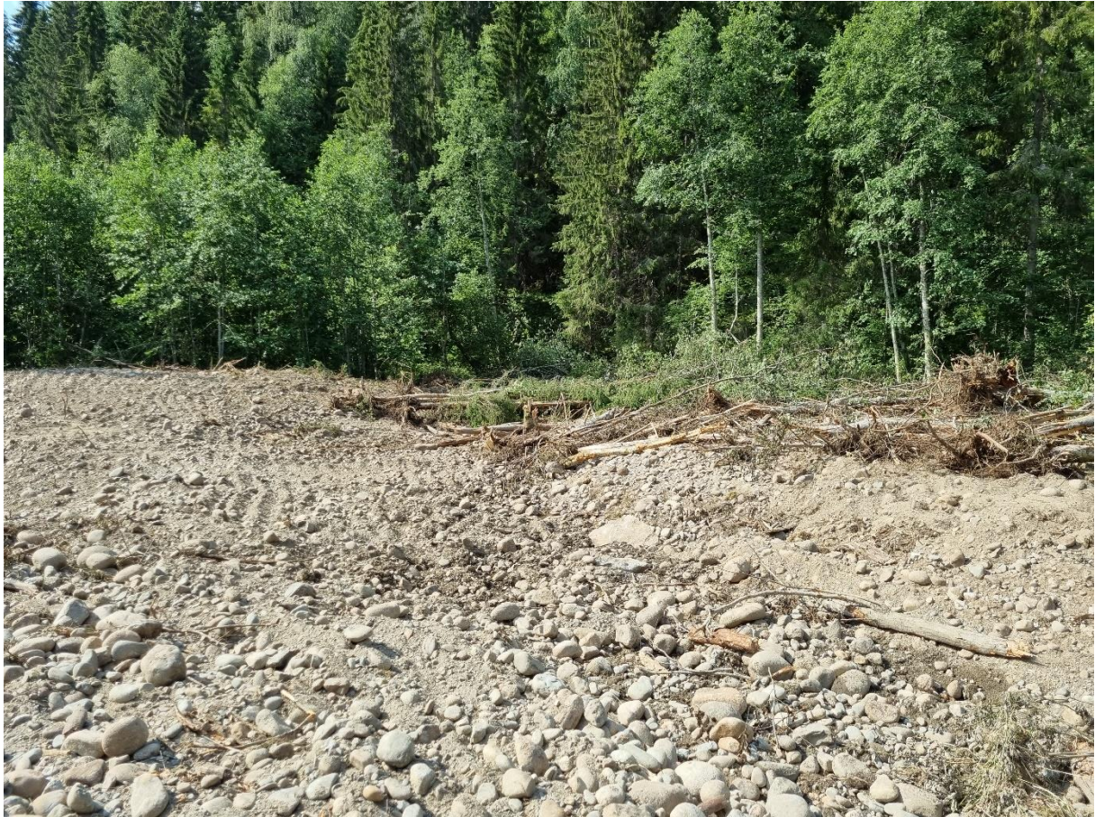
Bild 14. Efter öppning av högflödesinlopp till redan existerande sidofåra. Här syns det flacka inloppet som skapats. Objekt 4.
