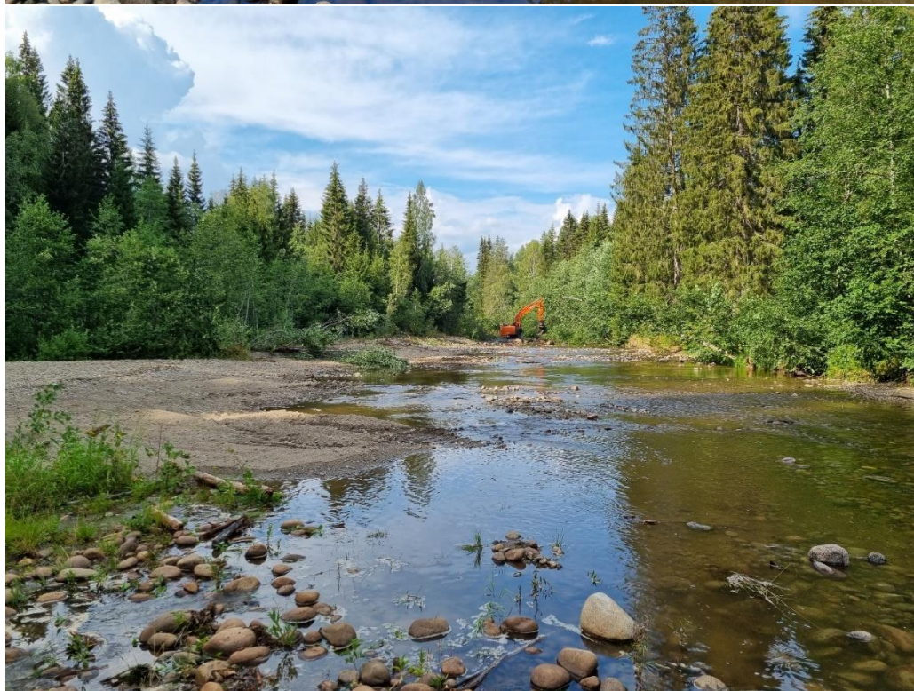
Bild 39 (ovanför). Förebild nedan Objekt 10. Bild 40 (nedanför). Efterbild nedan objekt 10. Bredden och kontakten med svämplanen har ökat för vattendraget.
