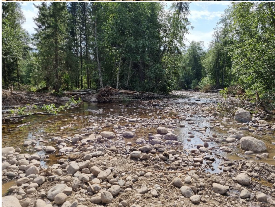
Bild 17 (ovanför). Förebild strax uppströms en sidofåra på river right som saknade kontakt med ån. Objekt 6. Bild 18 (nedanför). Efterbild strax uppströms en sidofåra på river right som innan åtgärd saknade kontakt med ån. Nu rinner vattnet åter i sidofåran. Objekt 6.
