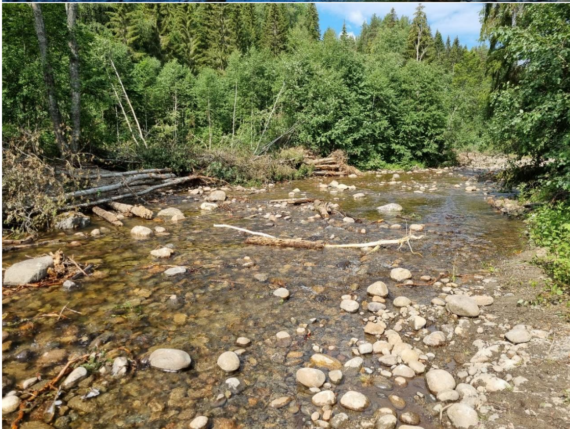
Bild 22 (ovanför). Förebild som visar nedströms objekt 8. Sträcka med kanaliserad karaktär och stenvall. Bild 23 (nedanför). Efterbild nedan objekt 8 som visar efter åtgärd vid sträcka med kanaliserad karaktär och stenvall. Stenmaterialet i vallen återfördes till ån vilket skapade en större bredd, mer variation på botten och en flikigare strand. Allt gynnar organismerna under ytan, inte minst öringens yngel.
