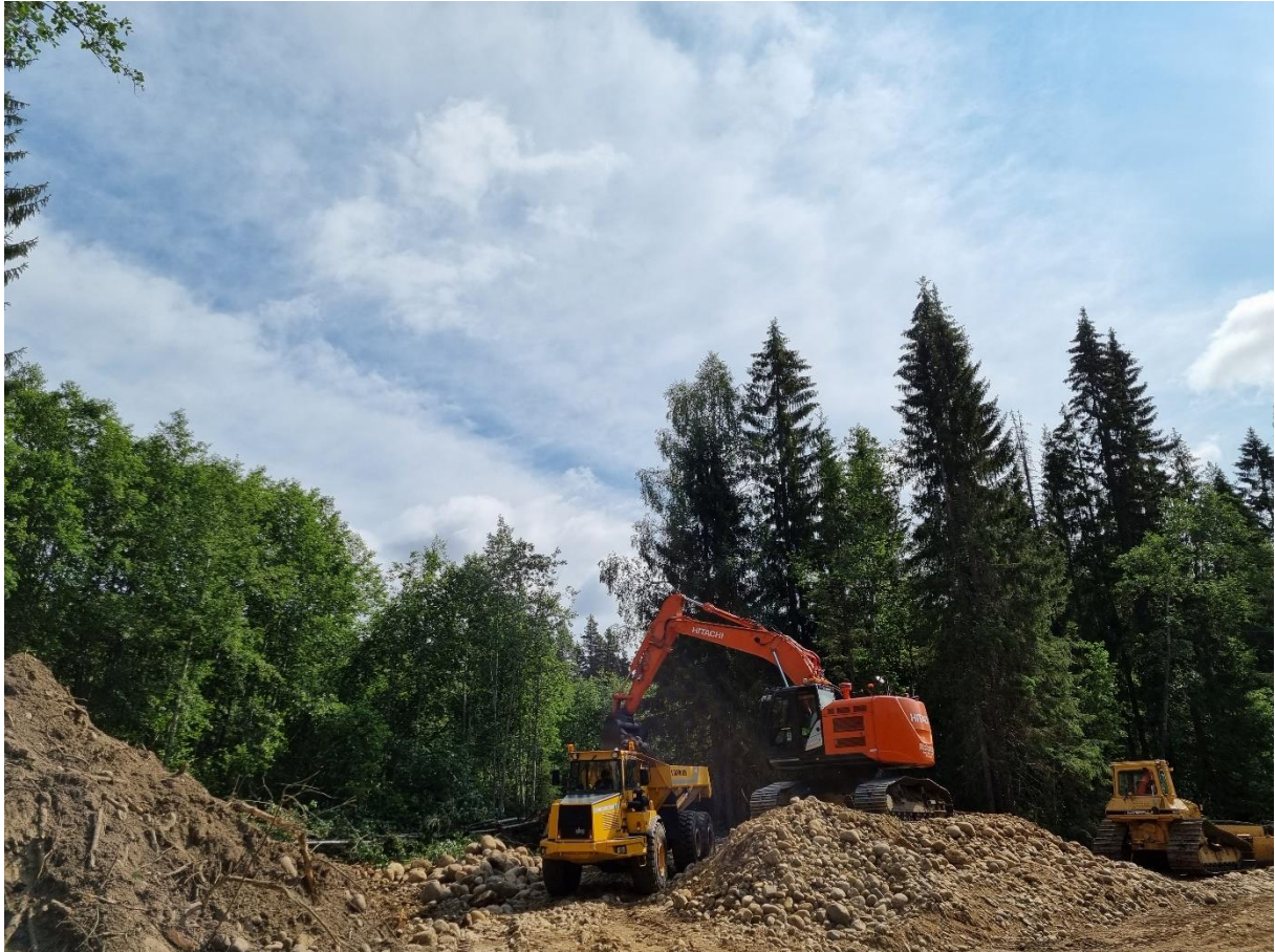
Bild 38. Pågående arbete med att återföra stenmaterial från de stora stenhögarna till åfåran.
