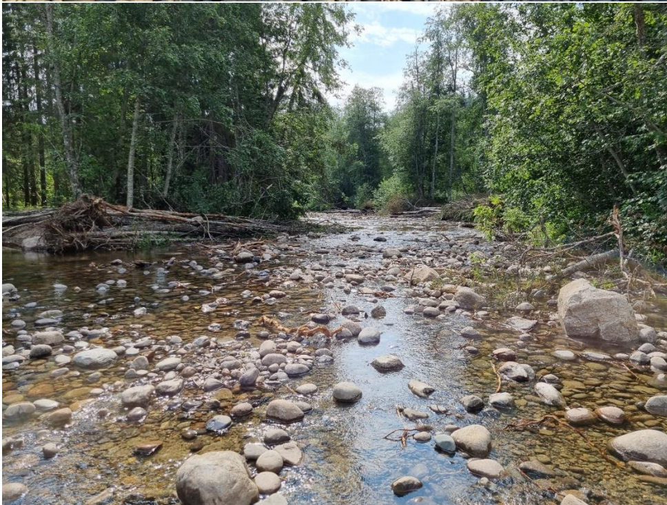
Bild 18 (ovanför). Förebild som visar sträcka med kanaliserad karaktär och stenvall på river right sidan. Objekt 7. Bild 19 (nedanför). Efterbild som visar efter åtgärd vid sträcka med kanaliserad karaktär där stenvallen river right har återförts till vattendraget samt dumperlast från objekt 9 har körts hit. Detta gav en stor höjningseffekt som gjorde att vattnet kunde rinna in i den nyöppnade sidofåran samt få mycket mer kontakt med svämplan. Även mängden bottenstrukturer ökade i stor utsträckning. Objekt 7.
