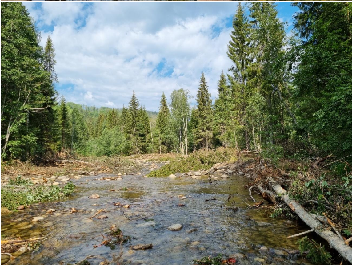
Bild 26 (ovanför). Förebild nedan objekt 9. Rensad sträcka med liten variation på botten och stenvallar i strandkanterna som gör det svårt för vattendraget att flöda in i svämplanen. Bild 27 (nedanför). Efterbild nedan objekt 9. En stor mängd stenmaterial återfördes till ån samt strandzonerna flackades. Detta skapade mer yta, mer varierad bottenstruktur och ån fick mer kontakt med svämplanen.
